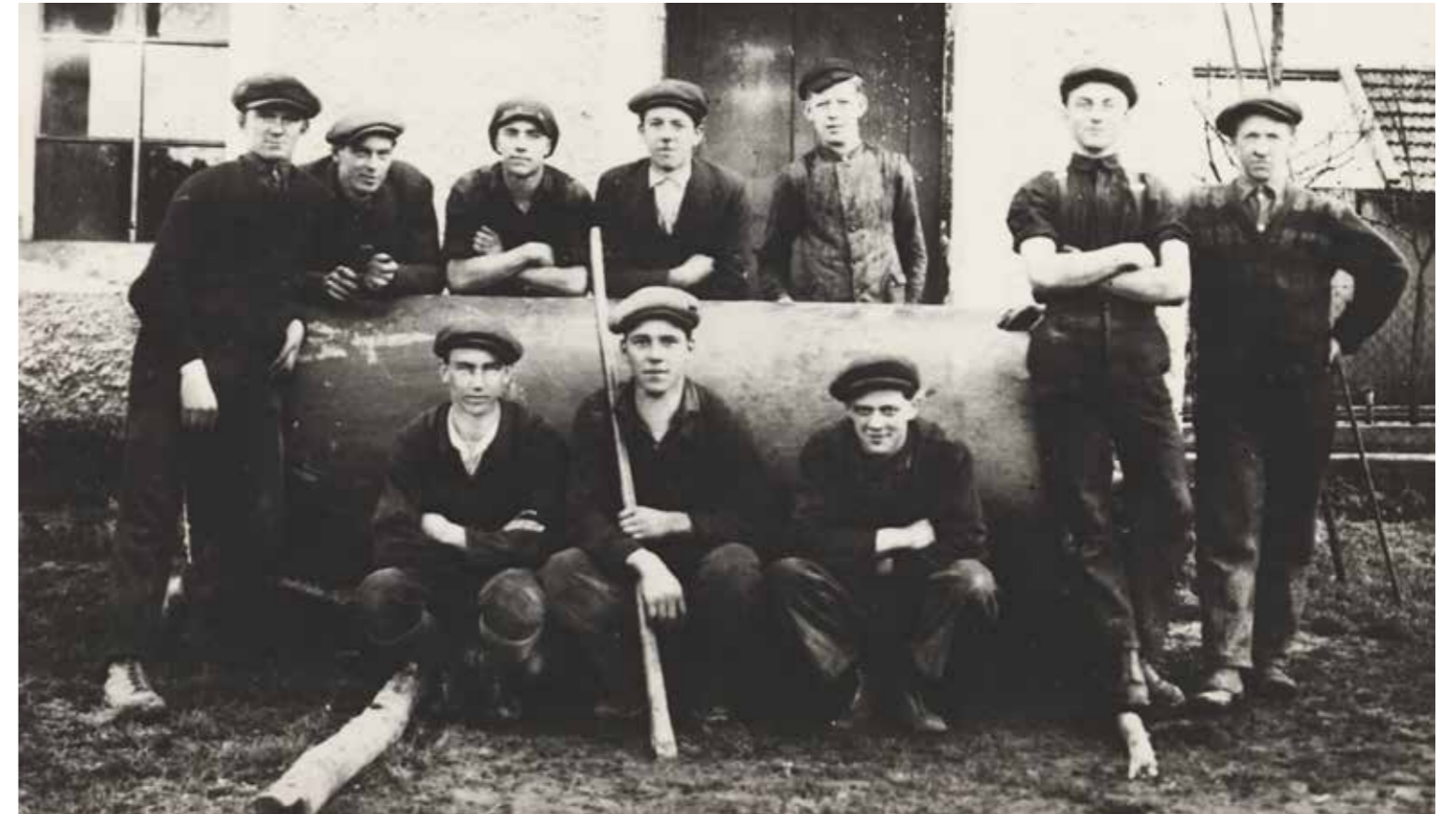
Skupina tekstilnih delavcev pri remontu črpalke na današnji Cankarjevi ulici v Kočevju, 1930
